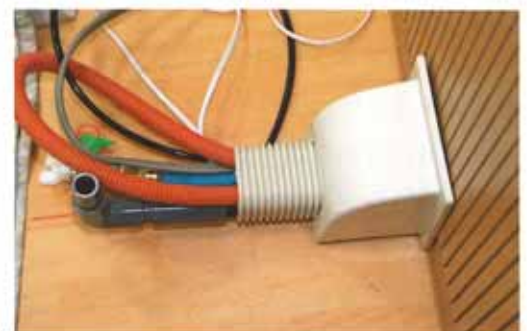
5. 壁からユニットへの配管
